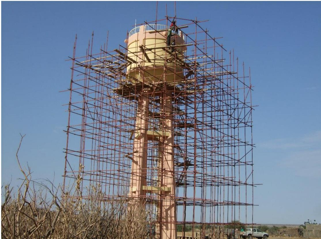
*Photo 24 - Echafaudage pour la réalisation de la cuve*
