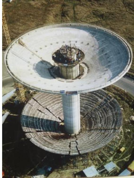
Photo 29 - Levée de la cuve par câbles
