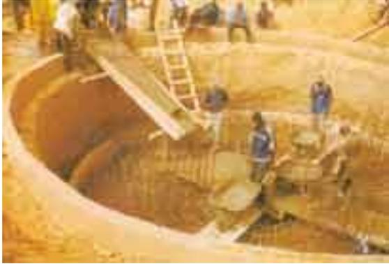
*Photo 9 - Début de réalisation d'une fondation de château d'eau après fouille*
