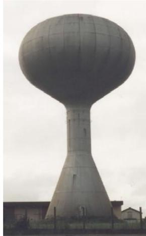
*Photo 6 - Réservoir à cuve sphéroïdale*
