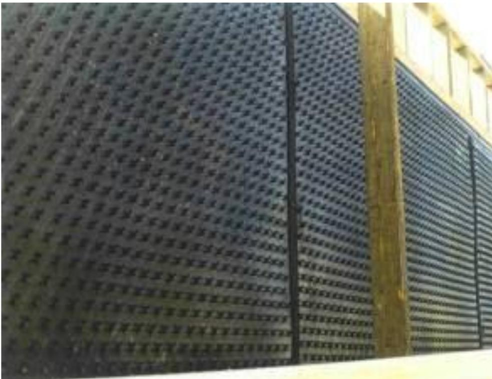
Photo 33. Mise en place de l'étanchéité sur les banches
