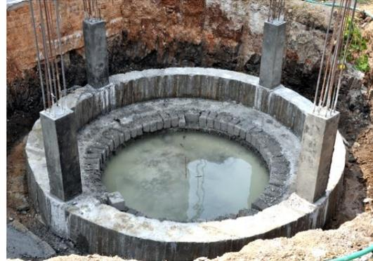
*Photo 8 - Fondation d'un château d'eau réalisée*
