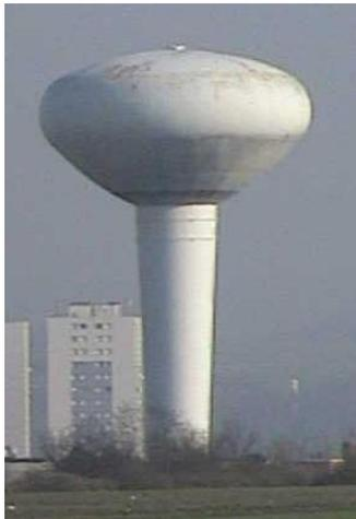
*Photo 7 - Réservoir à fond sphéroïdal*
