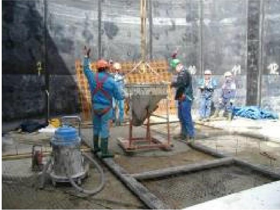
Photo 36 – Coulage du béton entre les nus
