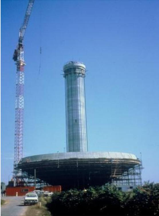
Photo 28 - Coffrage au sol de la cuve
