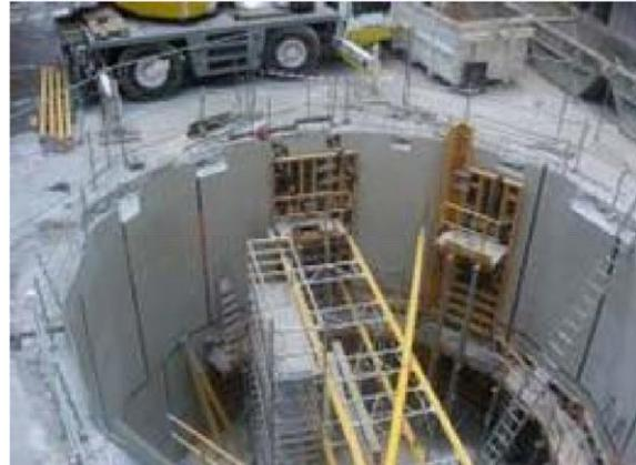
*Photo 42 – Vue d'ensemble de l'ouvrage avant le coulage du plancher*
