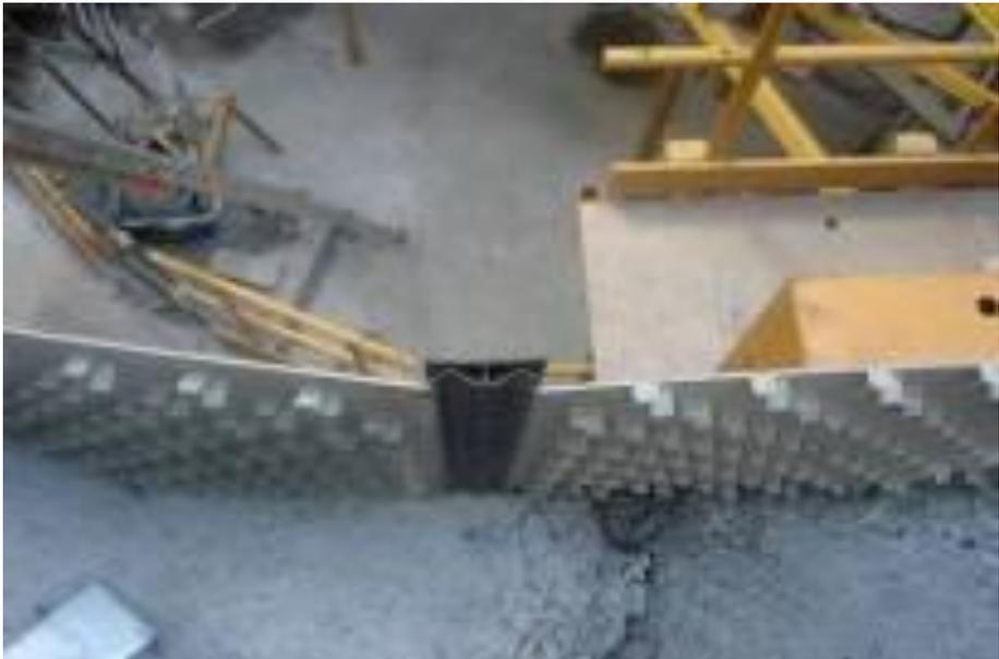
Photo 34 – Raccordement des panneaux par le Profilé « à déchirer »
