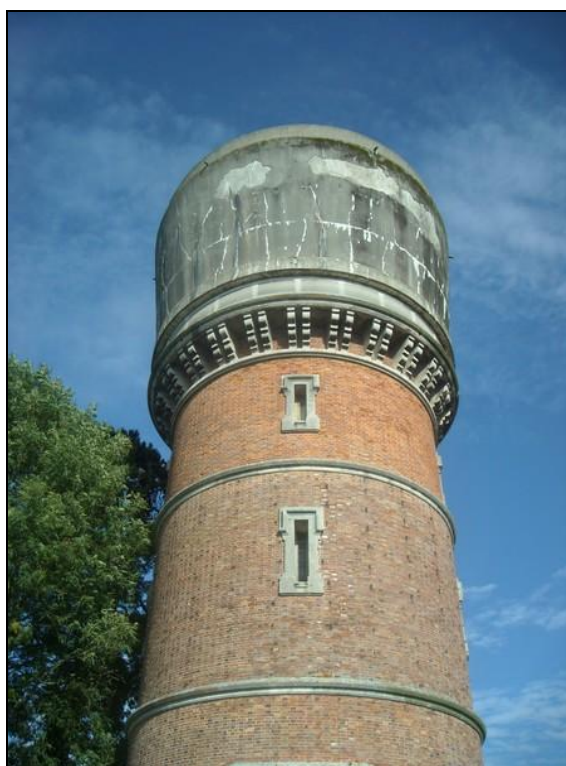
Photo 52 - Château d'eau de Ferrières-en-Brie
