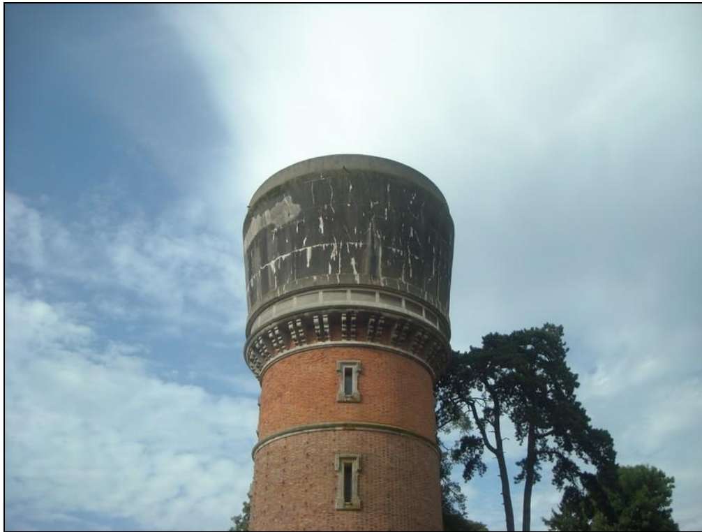
Photo 53 - Château d'eau de Ferrières-en-Brie
