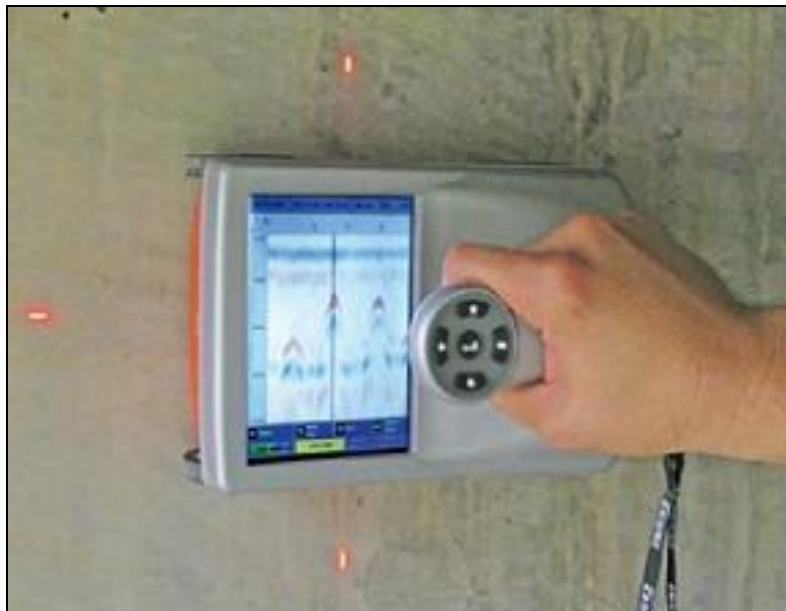
Photo 47 - Mesure d'enrobage d'armature au droit du fût
