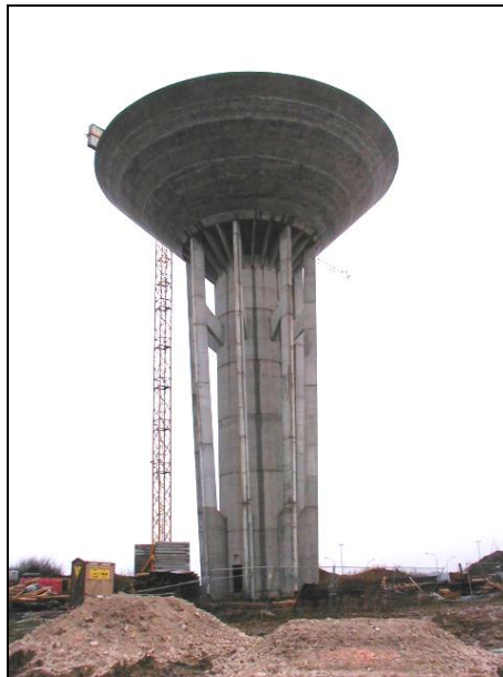
Photo 21 - Réalisation de la cuve
