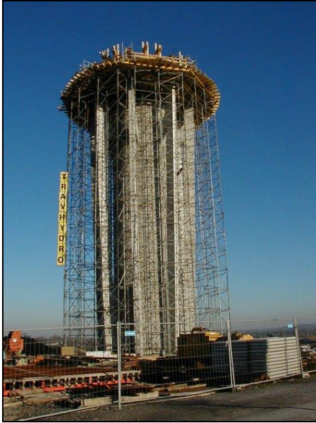
Photo 19 - Mis en place de l'échafaudage
