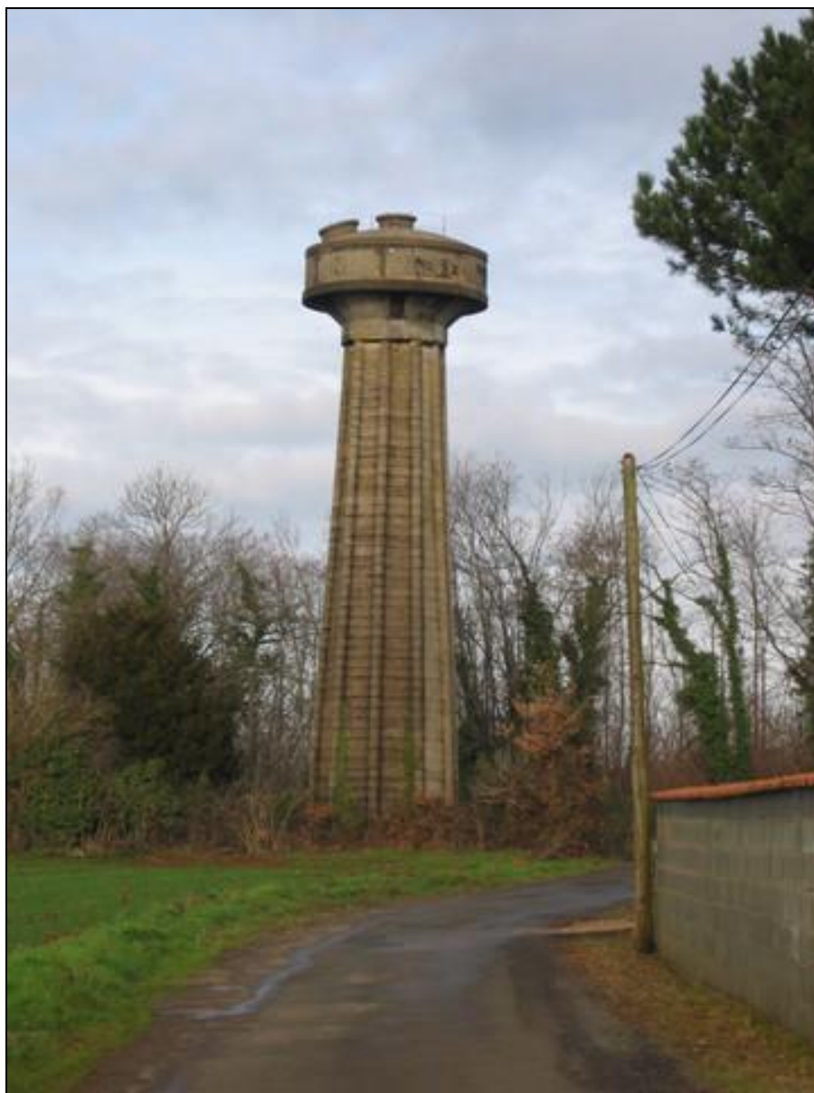
Photo 5 - Réservoir construit en 1934
