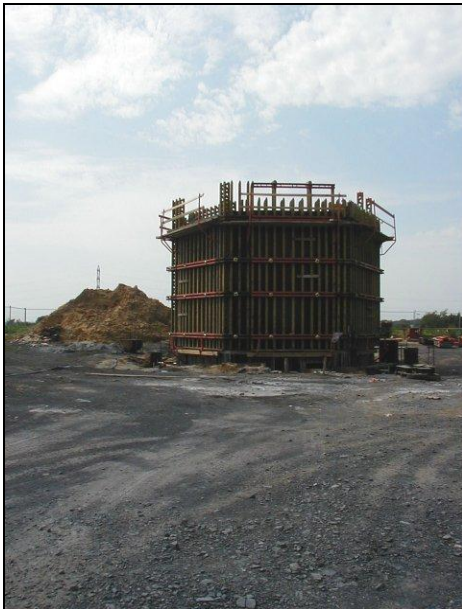
Photo 17 - Coffrage grimpant du fût
