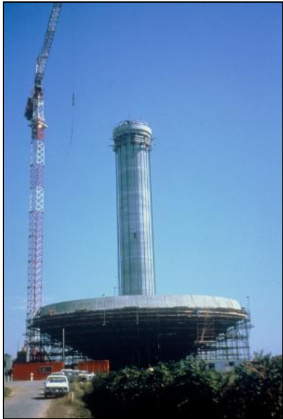
Photo 22 - Coffrage au sol de la cuve
