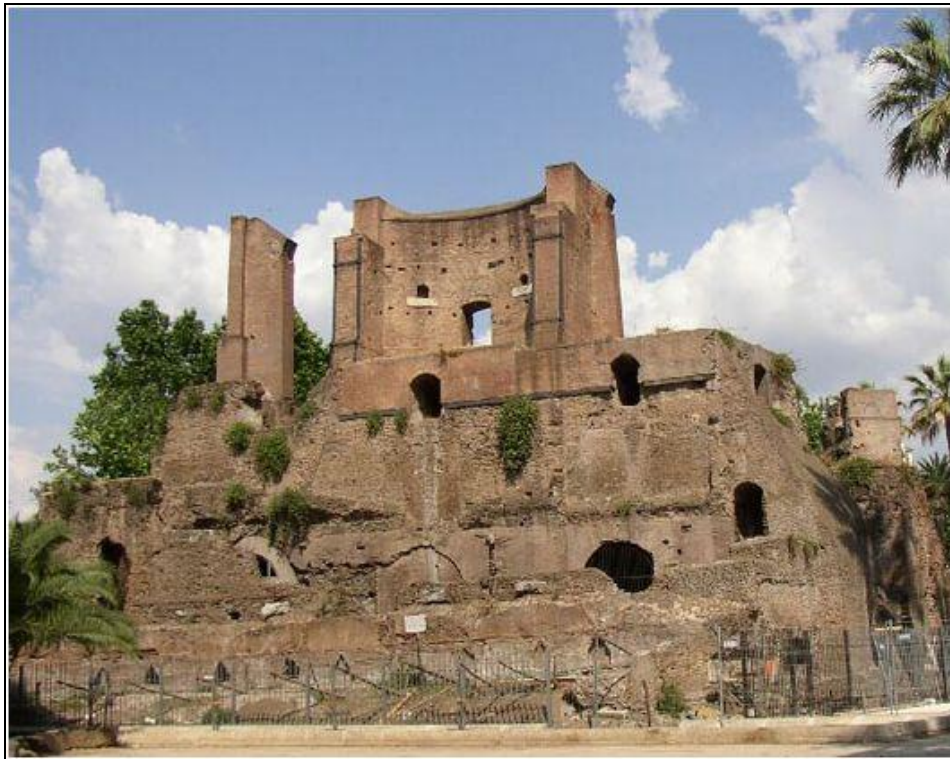
Photo 1- Vestige d'un château d'eau à Rome réalisé en l'an 226
