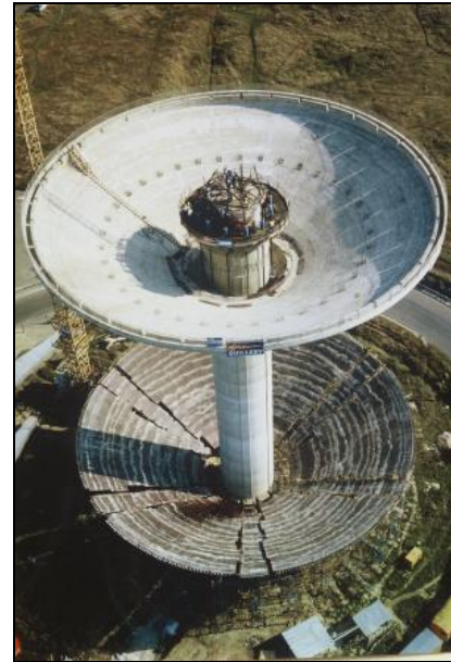
Photo 23 - Levée de la cuve par câbles
