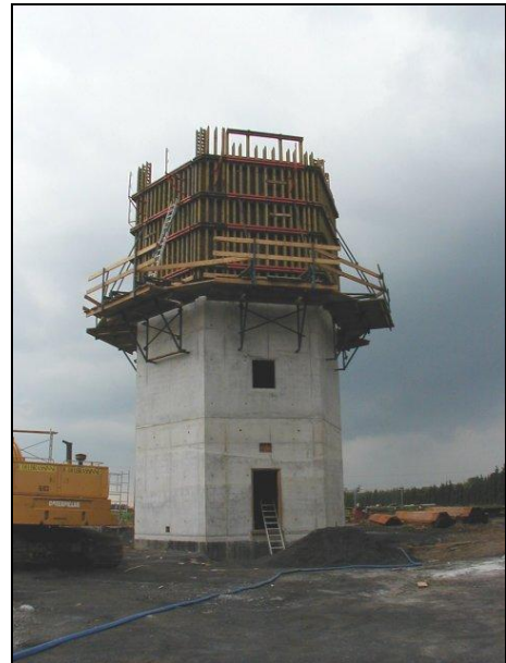
Photo 18 - Coffrage grimpant du fût
