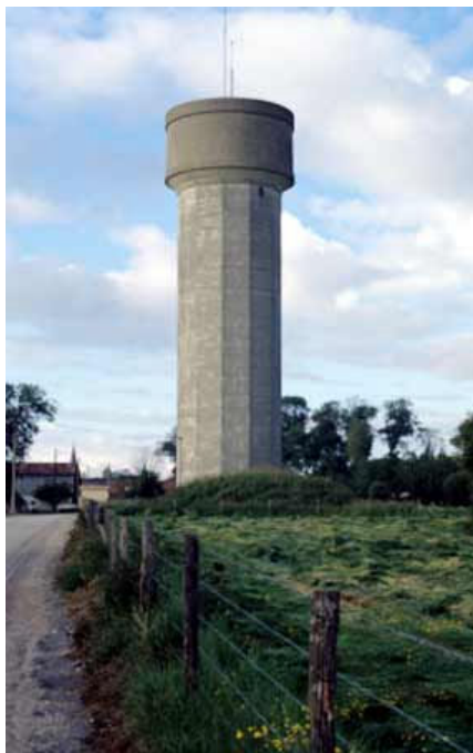
Le château d'eau de Saint-Martin-en-Campagne en 1991 avant décoration
