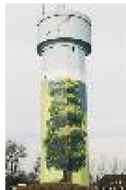
Le château d'eau de Saint-Martin- en-Campagne en 2005 après décoration
