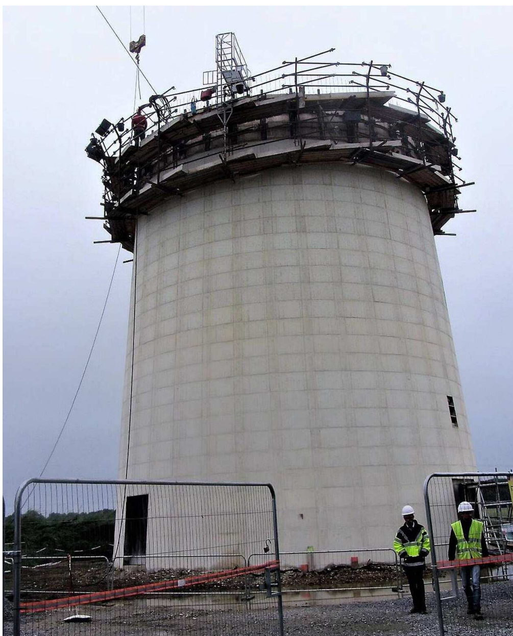
Le réservoir sur tour, type diabolos, en construction à La Bernardière. | Ouest-France
