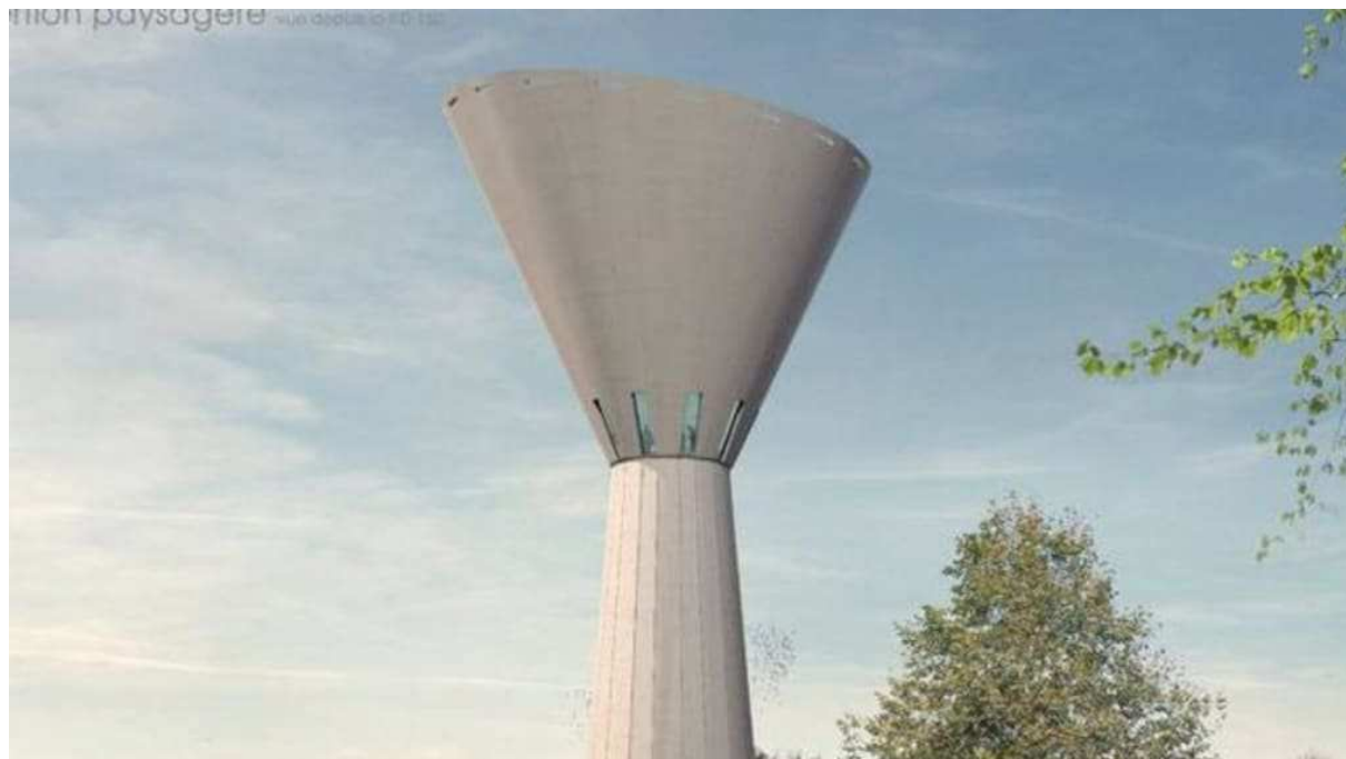
Le château d'eau de 46 mètres devrait voir le jour en 2014 au lieu-dit « la Boulaie ».
