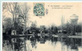
Le réservoir métallique sur pylônes
