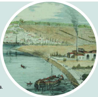
Nouvelle pompe à feu destinée à fournir l'eau aux rivières du Vésinet.
