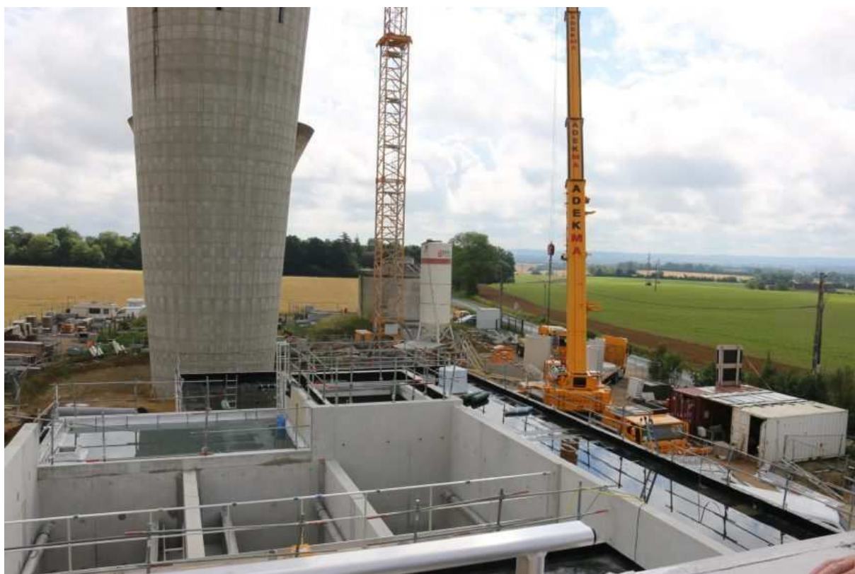
Une partie du chantier avec au premier plan les bassins de rétention d'eau. (@Le Perche)
