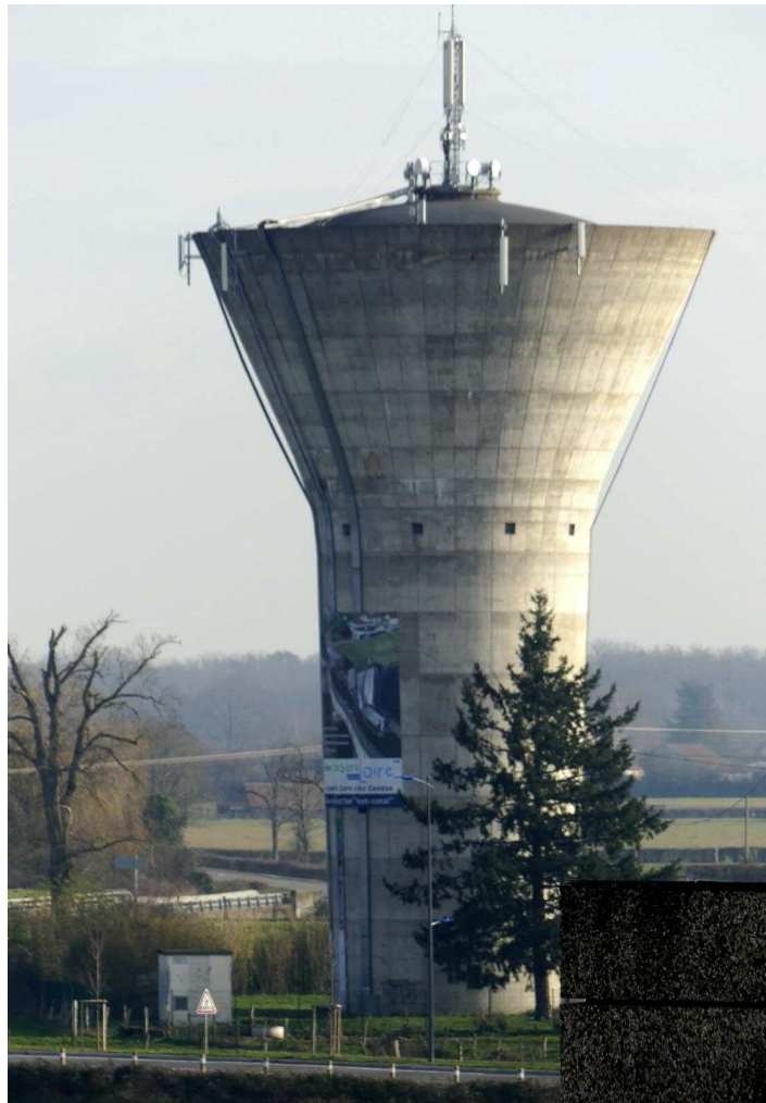
Du haut de ses 35 mètres, le château d'eau surplombe Digoin.
