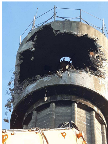
Le grignotage du château d'eau a commencé par son dôme qui servait de réservoir d'eau.
