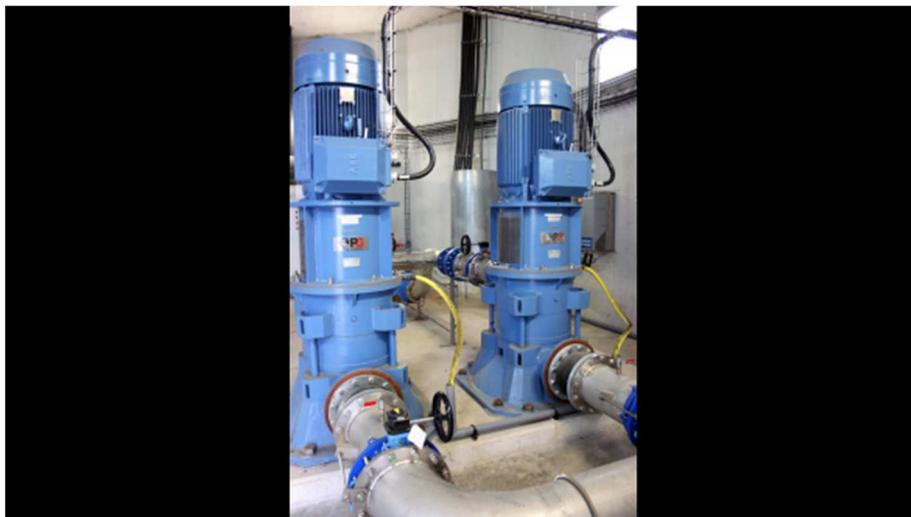
Deux pompes sont installées à l'intérieur du château d'eau jouant un rôle crucial dans l'exploitation et la distribution d'eau potable.
