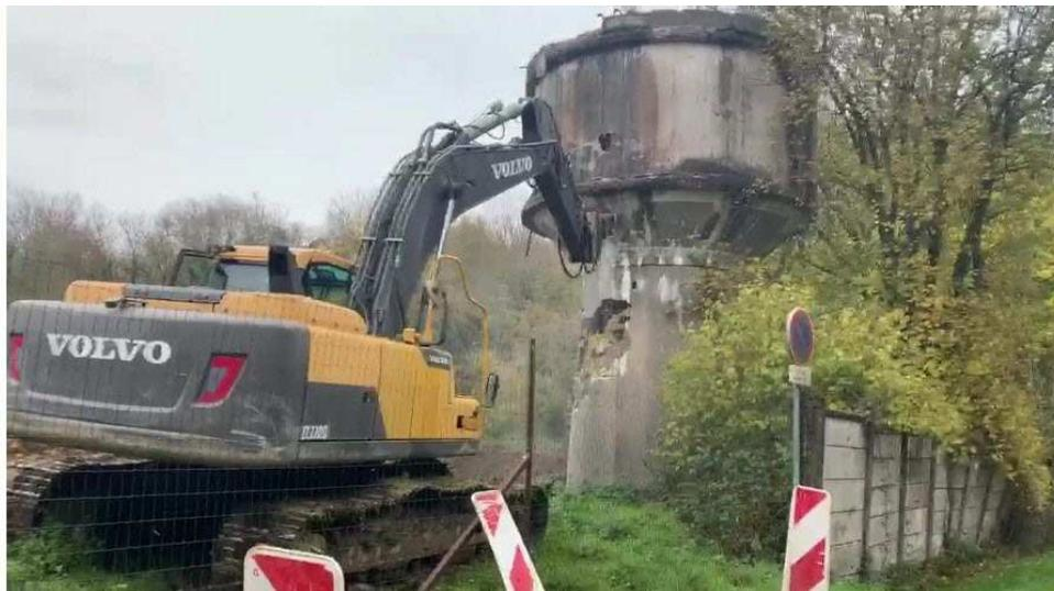
*La pelleuse, grâce à son croc à béton, entame la base du château d'eau. Photo RL*
