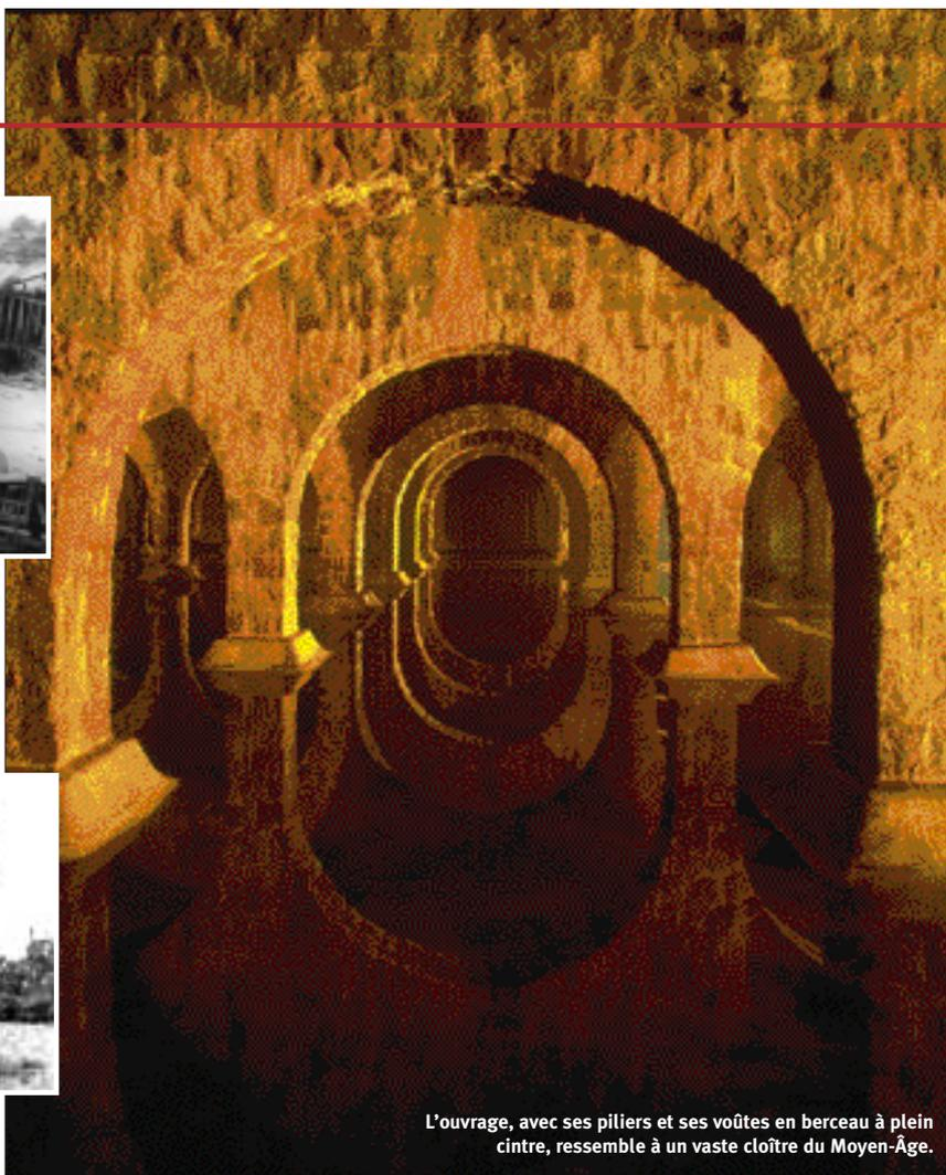
L'ouvrage, avec ses piliers et ses voûtes en berceau à plein cintre, ressemble à un vaste cloître du Moyen-Âge.
