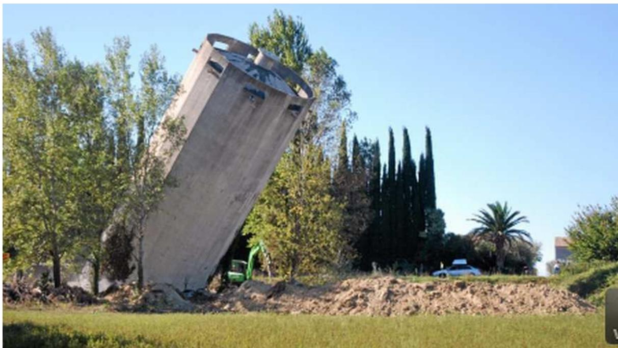
*La construction s'est effondrée en quelques secondes, ses 250 tonnes de béton se cassant dans une fosse préparée à l'avance. (FREDERIC AMADON)*
