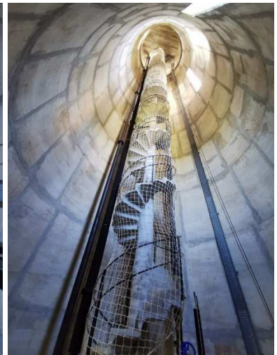
vue du 1er étage
