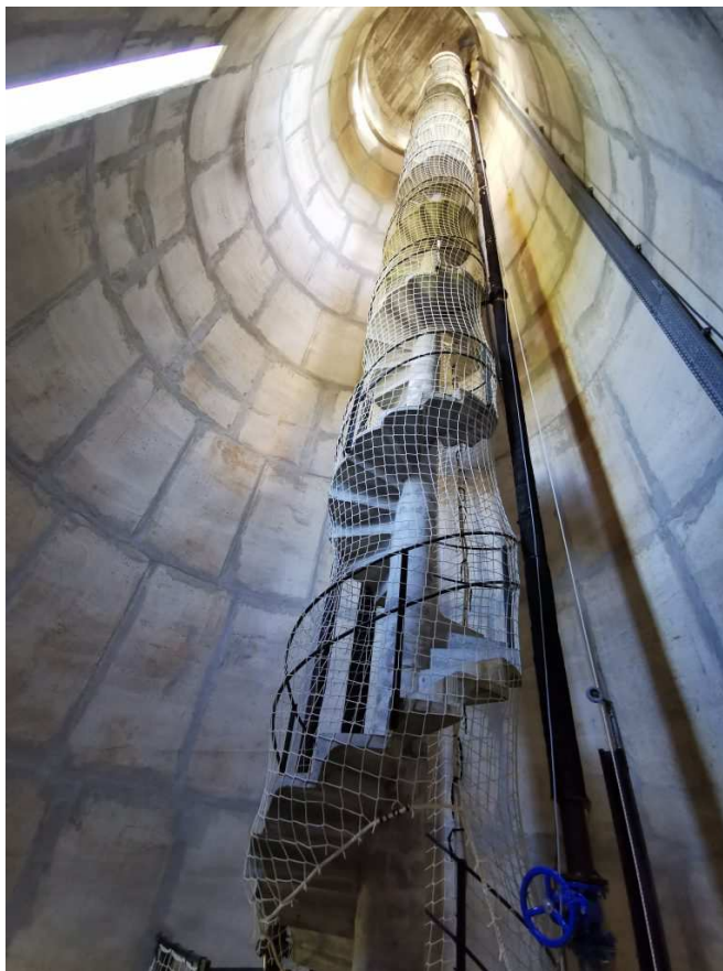
Colimaçon vers le 2ème étage
