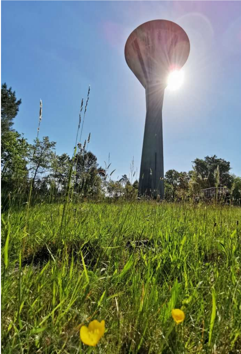
Périmètre de protection de l'ouvrage
