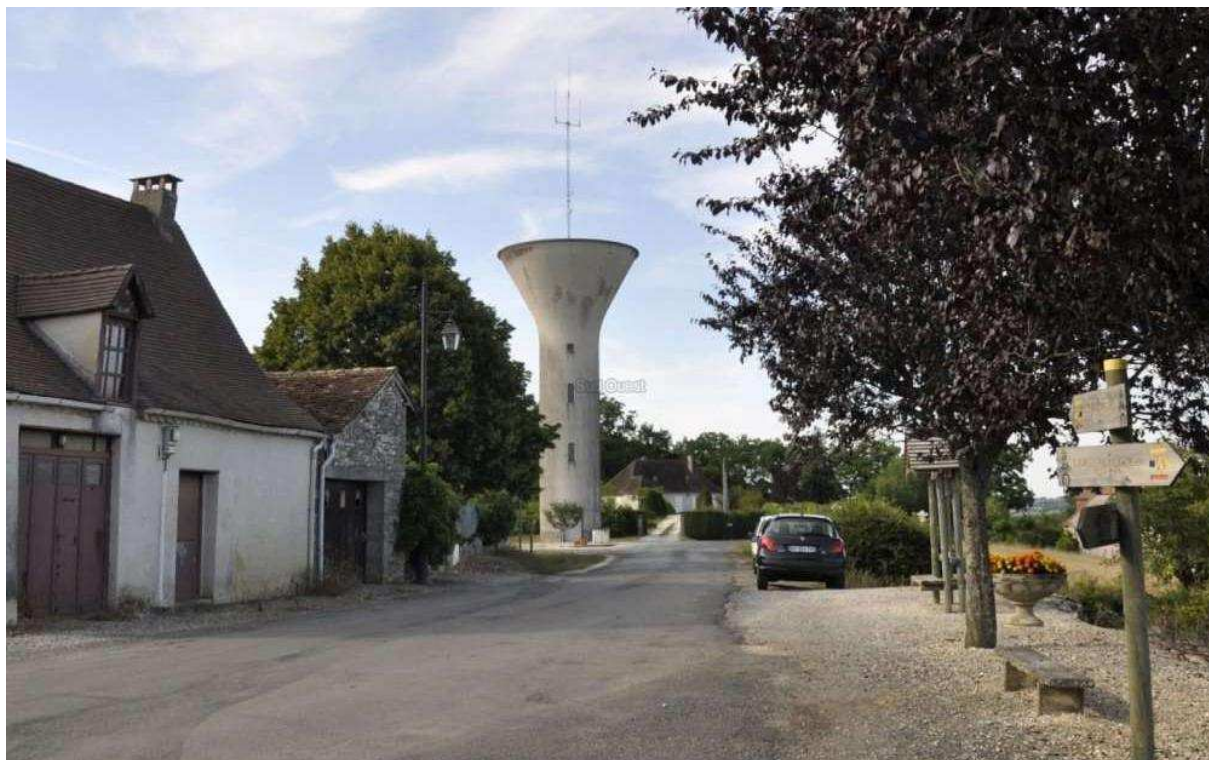
Le château d'eau de Saint-Raphaël était un point de repère à des kilomètres à la ronde
