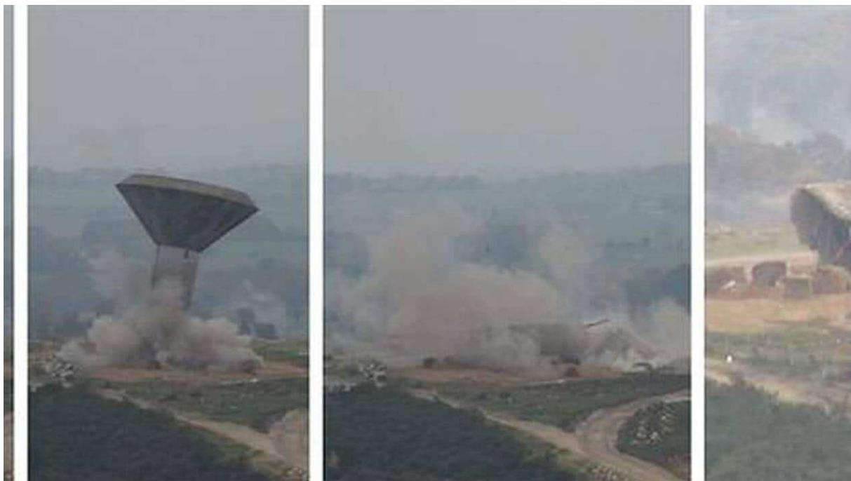
De gauche à droite : la mise à feu, le château d'eau qui s'incline tel un arbre qu'on abat. Et l'ultime phase de l'écroulement. L'édifice s'est totalement désarticulé. © OF
