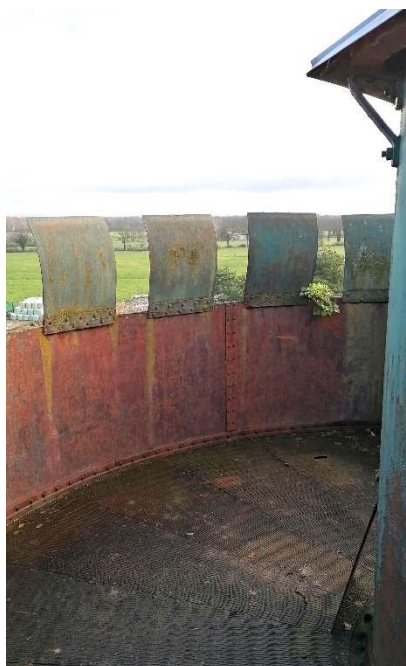
La terrasse : le plancher et le crénelage sont en métal
