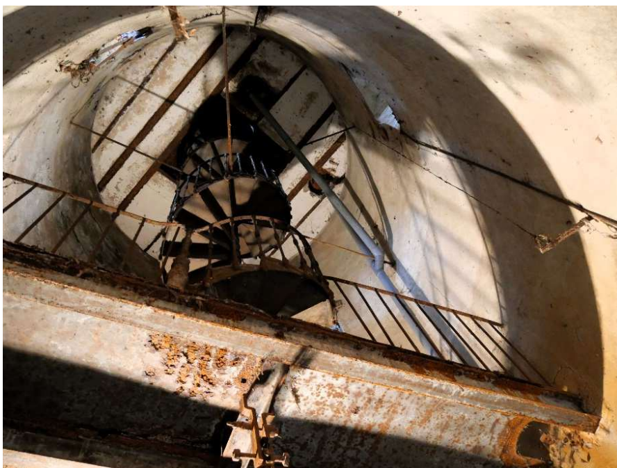
L'escalier traverse un plancher puis passe au milieu de la cuve
